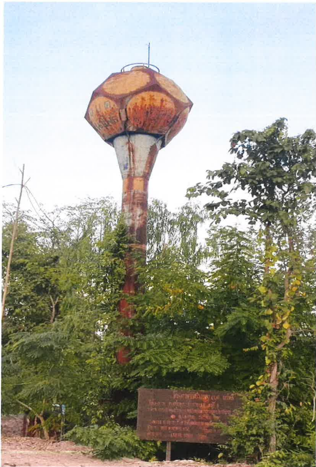
โครงการก่อสร้างระบบประปาหอถังสูง บ้านเมืองเก่าหมู่ ๘ รหัสครุภัณฑ์ ๑๐๓-๖๐-๐๐๑๒
