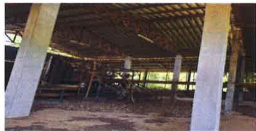
ก่อสร้างโรงสีข้าว ๒๘๖-๔๖-๐๐๐๑
